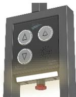
Em caso de falha de energia ou se a fonte de alimentação do controlo do elevador for interrompida por qualquer motivo, o sistema muda automaticamente para o modo de reserva. Isto significa que o sistema continuará a funcionar, uma vez que o elevador é então alimentado por uma bateria de reserva. O painel de controlo permanecerá iluminado. Um alarme acústico irá alertar o utilizador de que esta não é uma "situação de funcionamento normal".
